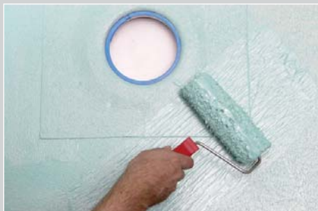
Нанесение гидроизоляционного состава HIDROFLEX на приклеенный пластырь LITOBAND P
